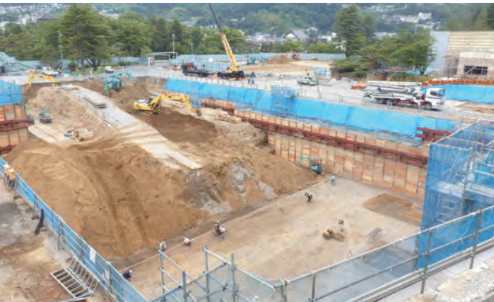
最下部まで掘削した現場の様子 [2019年6月]
