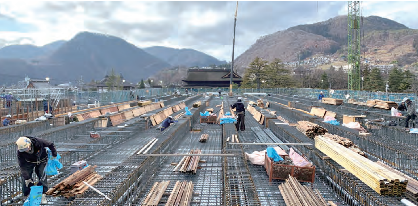
屋上広場部分の配筋工事 [2019年12月]
