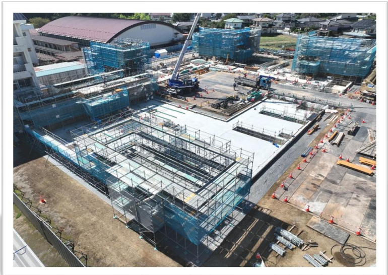
2026.09.24 北東側より鳥瞰 1階壁配筋～壁型枠～コンクリート打設実施状況
