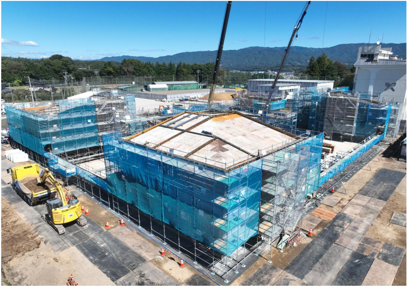
2026.09.30 屋根型枠施工状況
