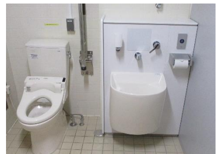
1階多目的トイレ
