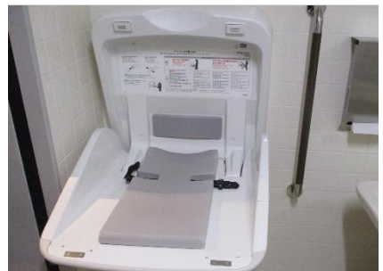
1階多目的トイレ
