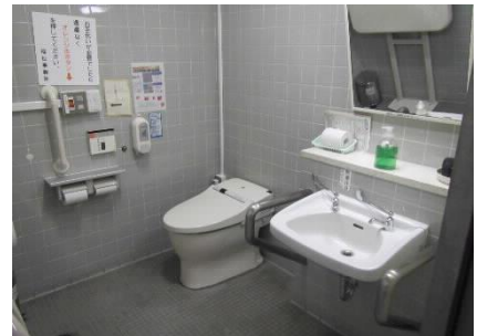
車いす対応トイレ内
