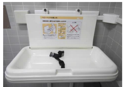
車いす対応トイレ内
