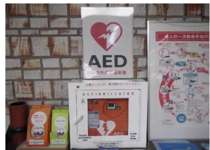
1階エレベーターホール北側
