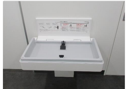
2階多目的トイレ
