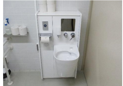
2階多目的トイレ
