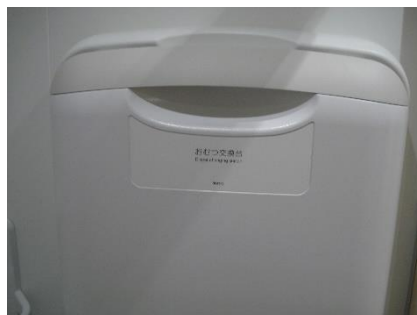
1階女子トイレ内
