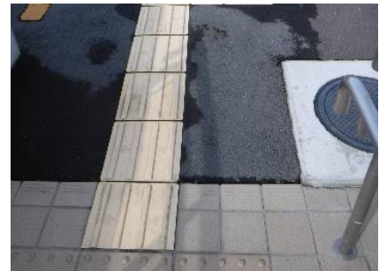
西側道路から玄関への通路
