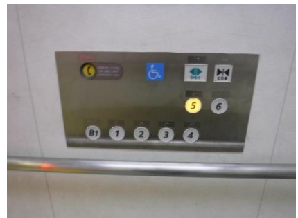
エレベーター内
