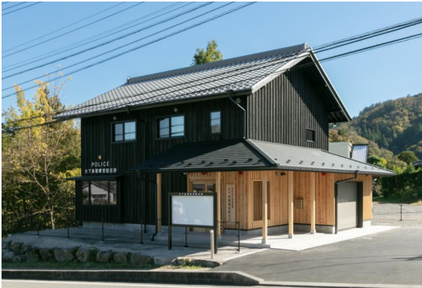
設計者：中山建築設計事務所（長野市） 施工者：小池建設株式会社（飯田市）
