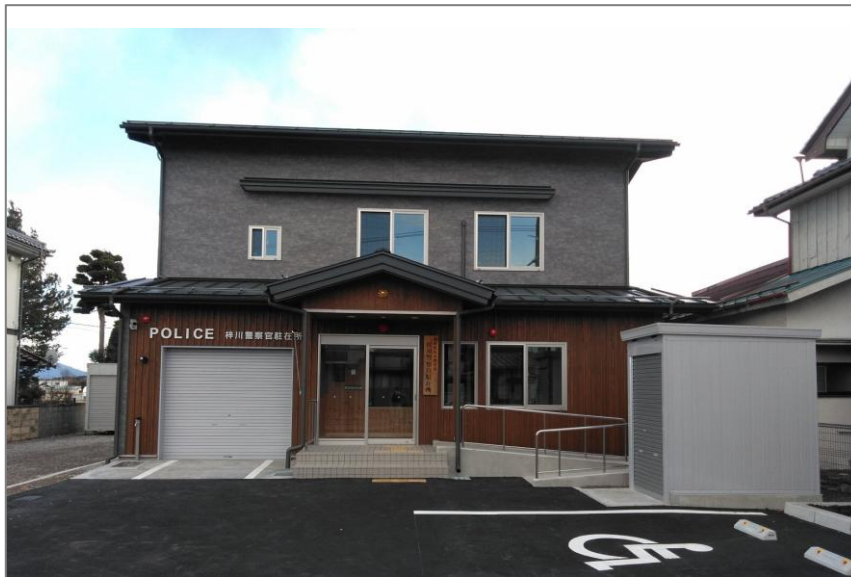
設計者：株式会社伊藤建築設計事務所（松本市） 施工者：株式会社第一工務店（松本市）
