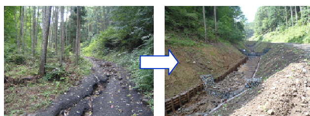
「溪畔林型」の整備例 沢が本来の沢でなくなっているところを再生
