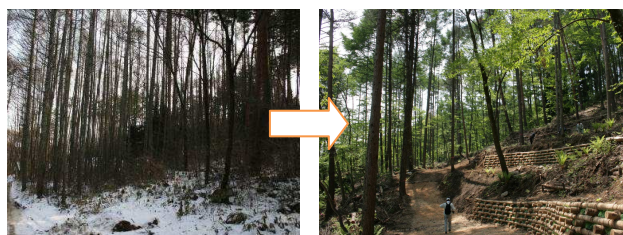
「崩壊防止型」の整備例 ゼロ次谷において本数調整伐、簡易治山施設を施工
