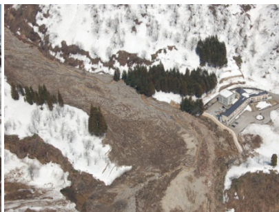
下水内郡栄村 中条川地区②
