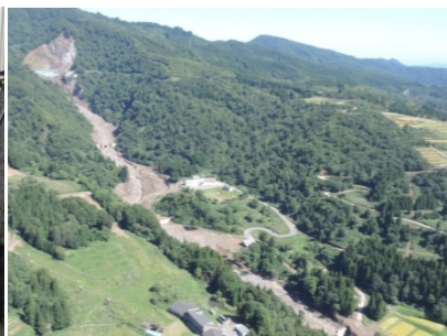
下水内郡栄村 中条川地区
