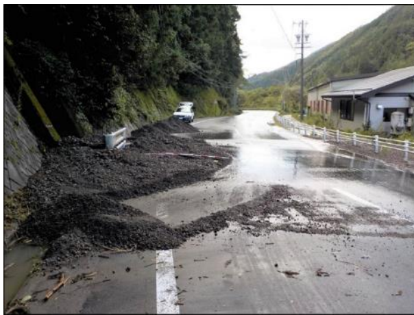
保全対象の被災状況
