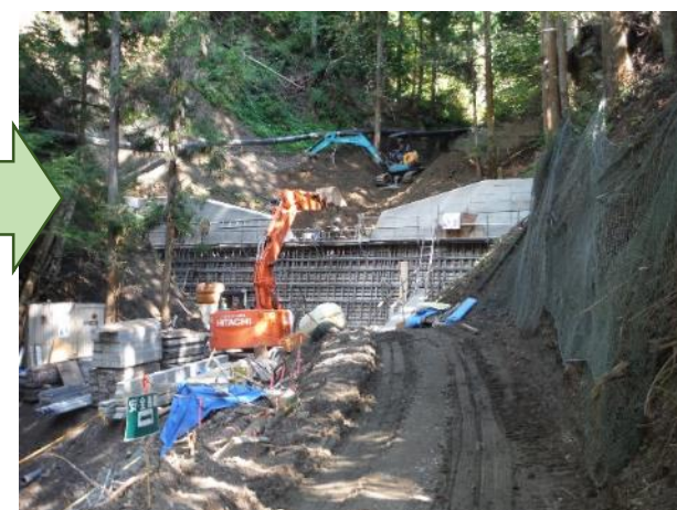
施工時の状況（令和元年10月撮影）
