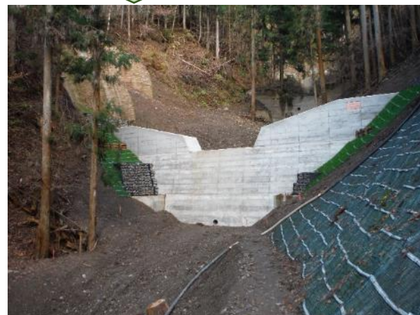
竣工の状況（令和元年12月撮影）
