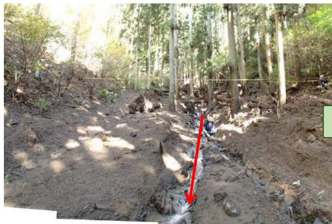
災害発生時の状況（平成29年10月撮影）
