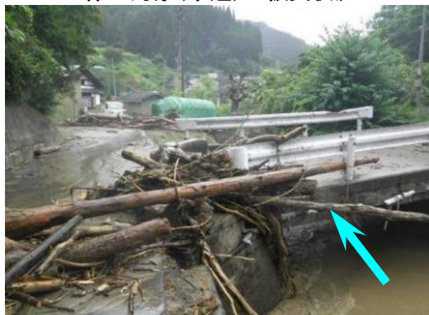
保全対象(市道)の被災状況
