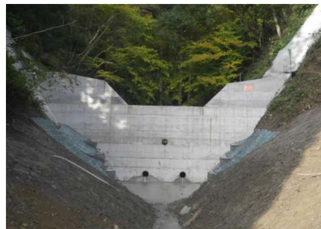
しゅん工時の状況（平成30年11月撮影）
