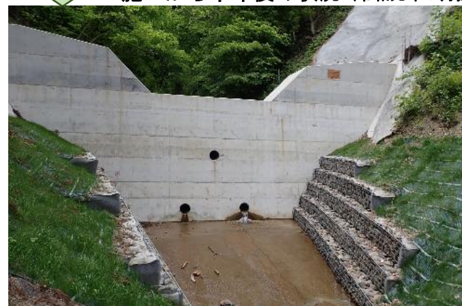
施工から半年後の状況（令和元年5月撮影）
