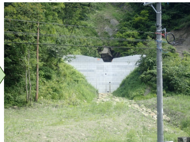
竣工後の状況（令和元年8月撮影）
