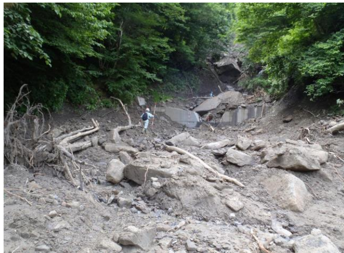
災害発生時の状況（平成29年7月撮影）
