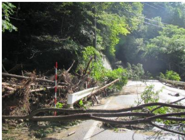
保全対象の被災状況
