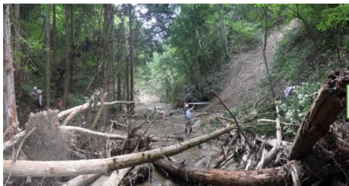
災害発生時の状況（平成27年9月撮影）
