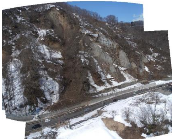
災害発生時の状況（平成27年3月撮影）
