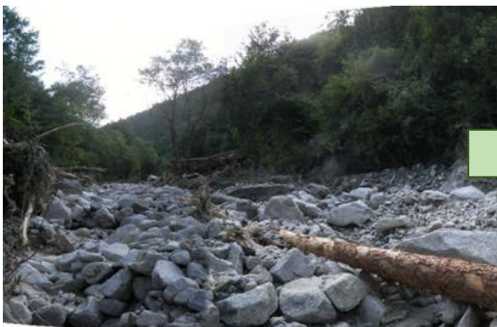
災害発生時の状況（平成25年9月撮影）
