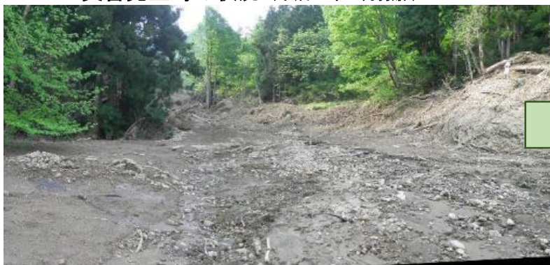
災害発生時の状況（平成24年5月撮影）
