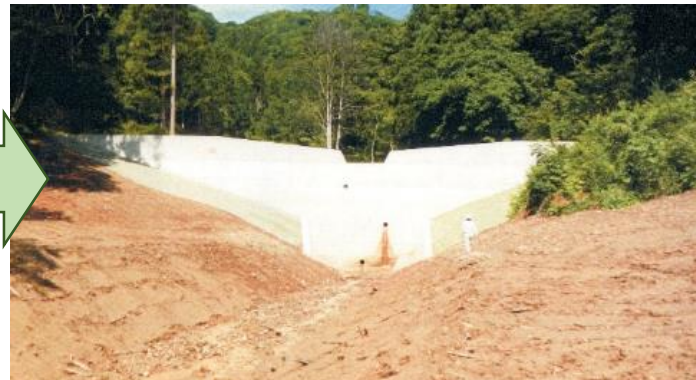
竣工時の状況（平成25年9月撮影）
