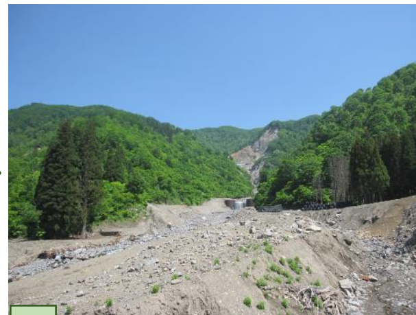
施工時の状況（平成26年5月撮影）
