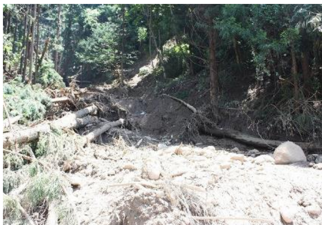
災害発生時の状況（平成22年7月撮影）
