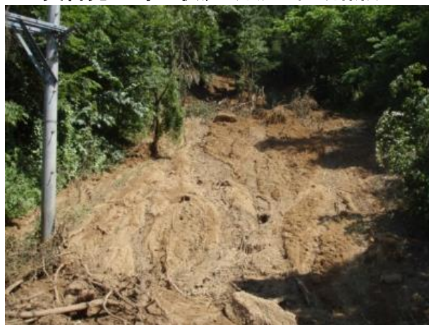
災害発生時の状況（平成22年7月撮影）
