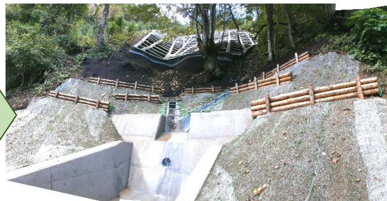
竣工時の状況（平成23年10月撮影）
