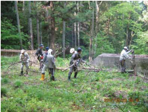
③ 谷止工堆砂敷の倒木整理
