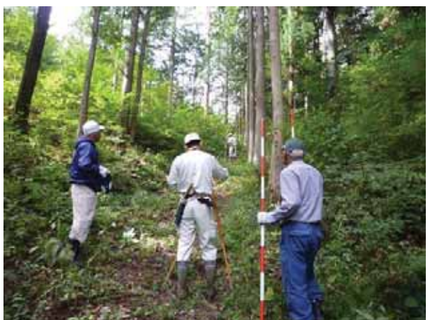
⑥ 開設する道の確認・測量（Facebook 投稿写真より）
