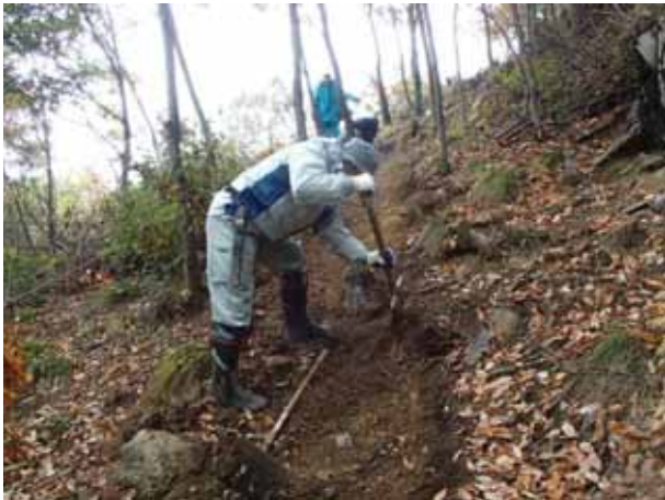
③ 遊歩道の整備・点検
