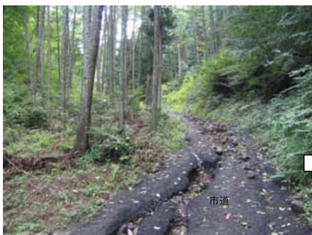
③ 施工前の状況（川と市道との比高差が無い）
