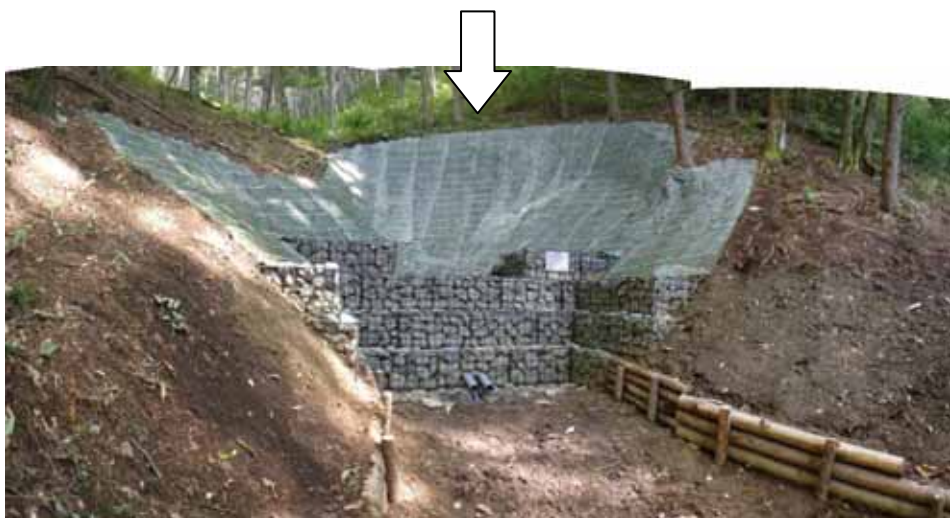
② 施工後の状況（カゴ枠床固工）
