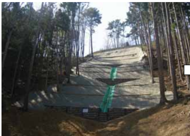
③ 施工後の状況（山腹工）
