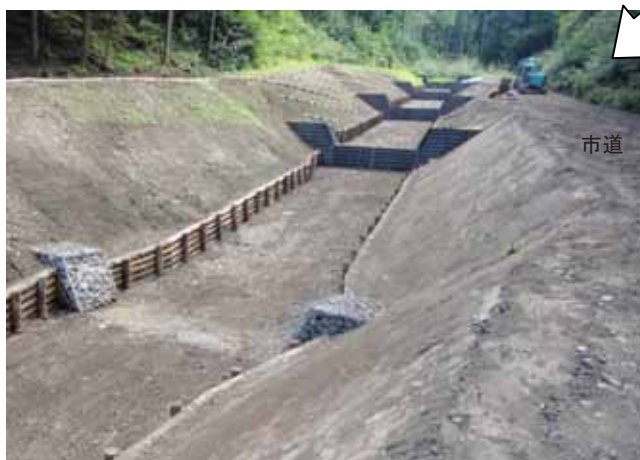
⑤ 施工中の状況（流路工）
