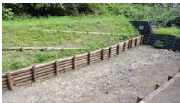
⑥ 施工後の状況（流路工）
