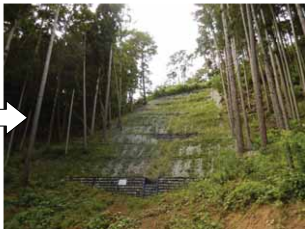
④ 施工から1年半後の状況
