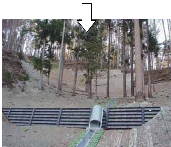
③ 施工後の状況（山腹工）
