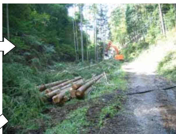
② 施工中の状況（溪流内のカラマツ伐採）
