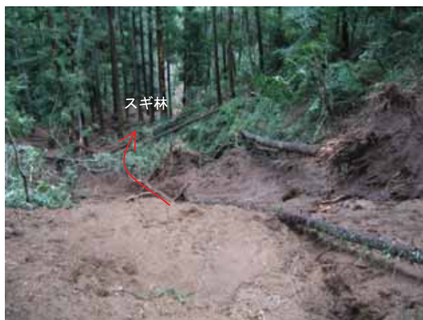
② 施工前の状況（上部からの状況）
