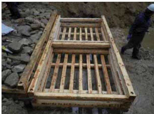
③ 施工中の状況（木工沈床）
