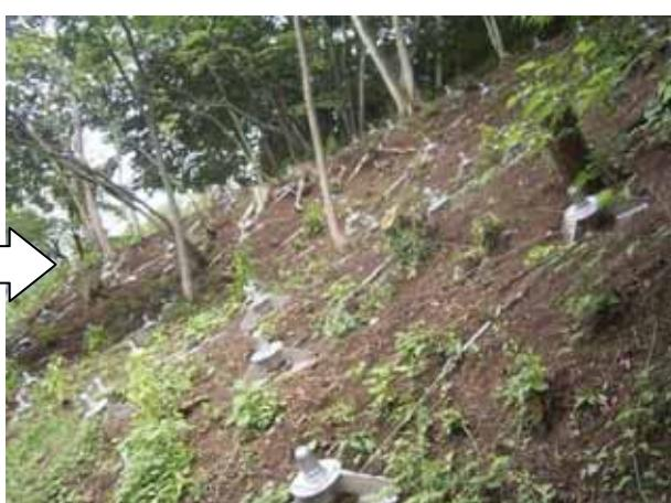
⑥ 施工後の状況（ノンフレーム工法＋立木整理）
