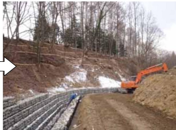
④ 施工中の状況（本数調整伐+筋工+護岸工）
