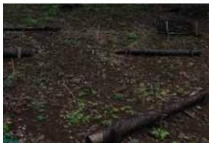
⑤ 伐木筋工の効果（左：施工から1年後、中：施工から3年後、右：施工から5年後）
