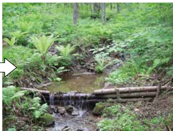
⑤ 施工後の状況（伐木溪床固定工）
