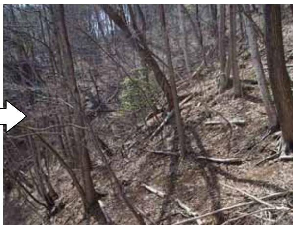
② 施工後の状況（本数調整伐＋伐木筋工）
