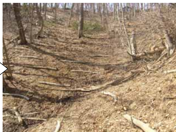
④ 施工後の状況（本数調整伐＋伐木筋工）
