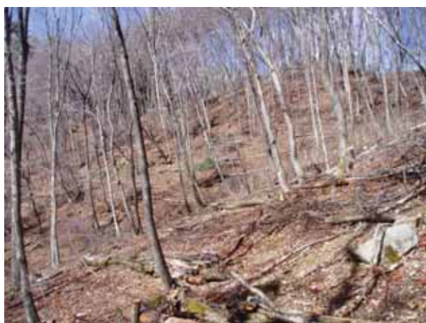
③ 施工後の状況（本数調整伐＋伐木筋工）
