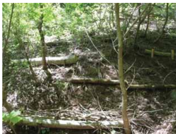
④ 施工後の状況（本数調整伐＋伐木筋工）
