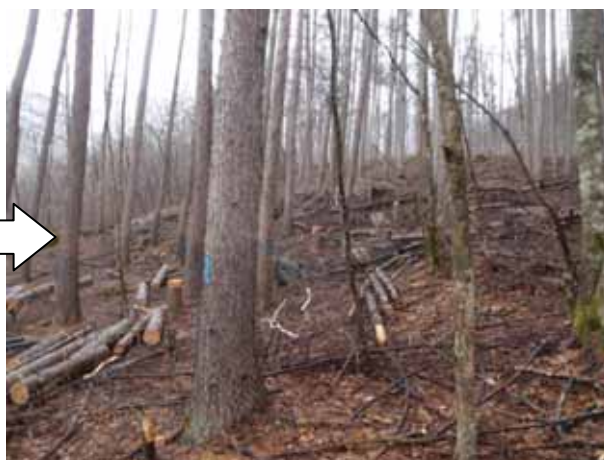
② 施工後の状況（本数調整伐）
