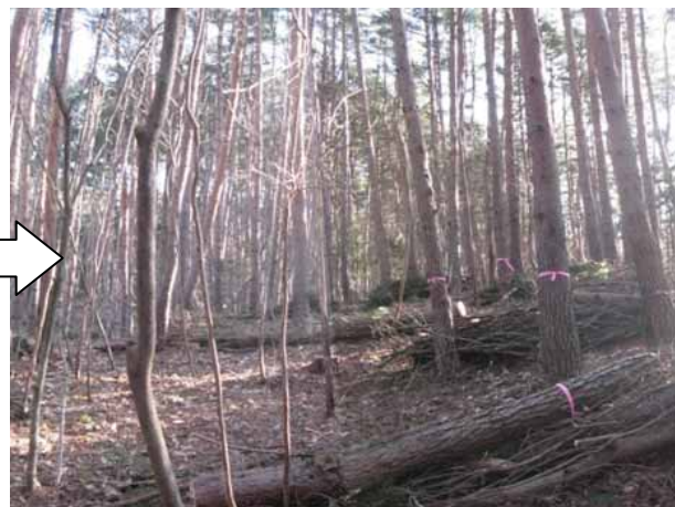
④ 施工後の状況（本数調整伐）
