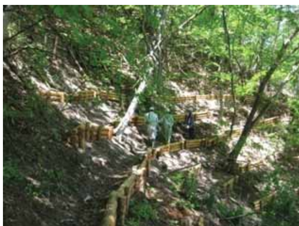
⑤ 施工後の状況（旧崩壊地には丸太筋工を設置）
