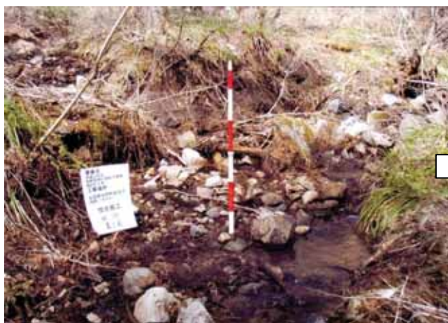
④ 施工前の状況（侵食が進行）
