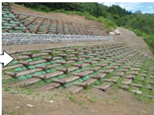
② カラマツ丸太で補強した押え盛土工
