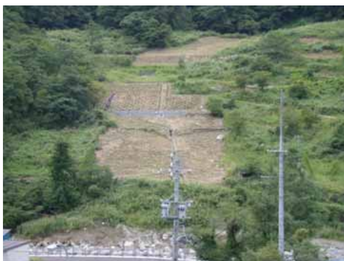
⑤ 施工後の状況（全景）
