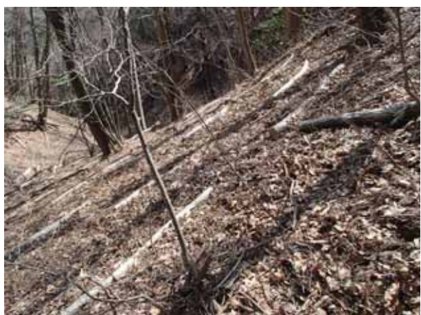
⑤ 施工後の状況（本数調整伐＋伐木筋工）
