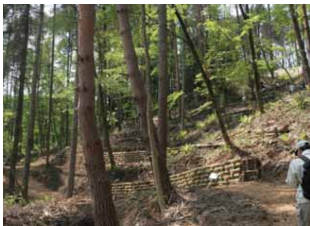
③ 施工後の状況（本数調整伐＋丸太積工）
