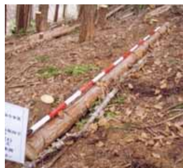
③ 施工後の状況（伐木筋工）
