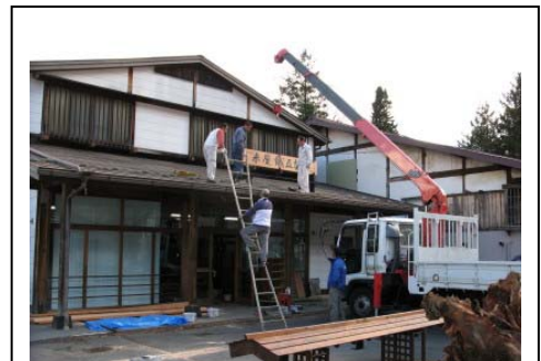
【「米屋鐵五郎本舗」改修作業】
