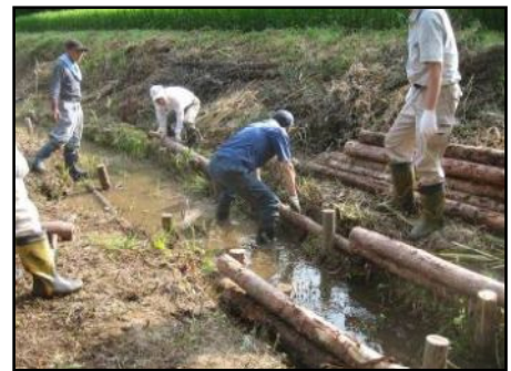
【水路整備作業の様子】
