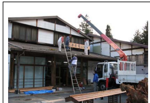
【「米屋鐵五郎本舗」改修作業】
