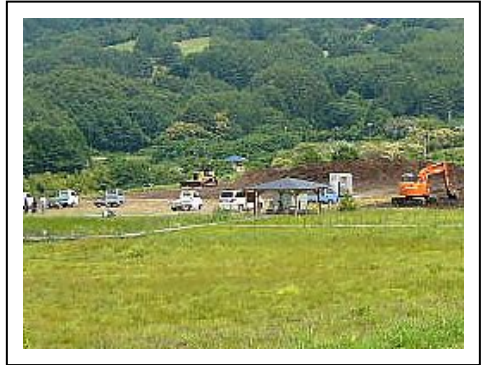
【環境整備作業の様子】
