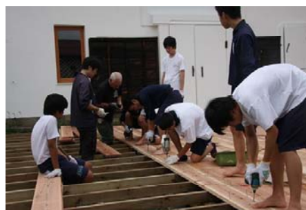
【学生とのウッドデッキ作り】
