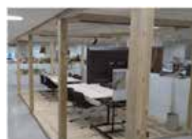
県庁林務部執務室内の木質化
