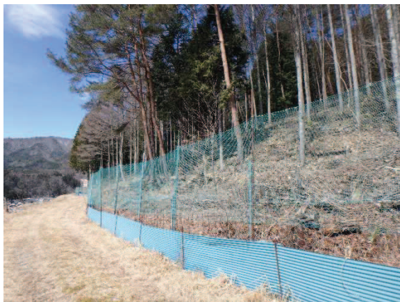
緩衝帯の整備 (平谷村 上の空地区)
