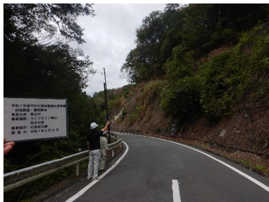
ライフライン等の保全整備 (豊丘村 村道黒谷線)
