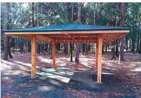
▲ 森林セラピーロード(南箕輪村)東屋の改修
