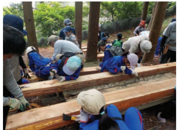
▲ツリーテラス製作作業(長野市)
