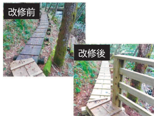
▲ 森林セラピーロード(阿智村)遊歩道の改修
