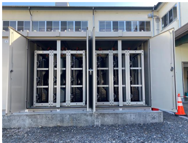
蓄電池システム：日東工業製 サファLink－ONE 日産リーフのリユースバッテリー 6パック
