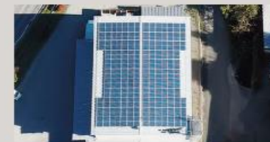
ハナブサ精機株式会社 鈴岡工場倉庫 飯田市飯科／出力33w、CO 2 削減量／19,656kg-CO 2 /kwh
