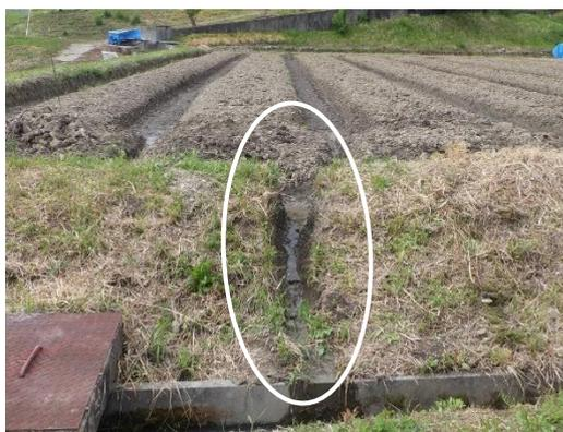
土手を切って、排水「溝」の水を河川等へ流す排水「口」を設置 (丸い枠の中)
