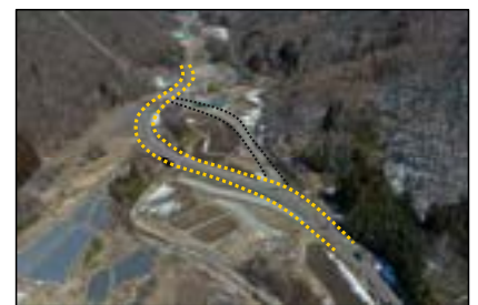
改良が進む現地の状況(事業区間南側から撮影)
