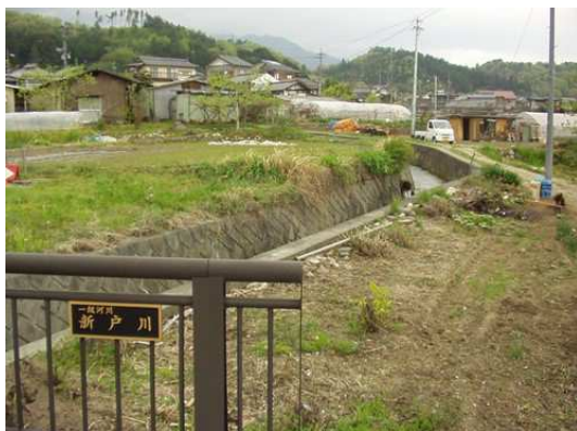
↓施工前の状況
