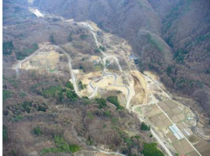
↓施工前の被災状況
