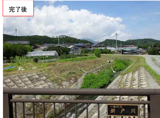
↓施工後の状況
