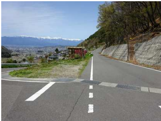
↓施工後の状況
