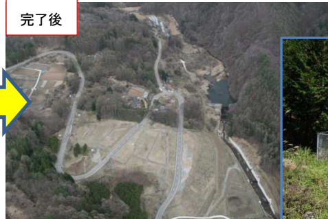
↓施工後の状況
