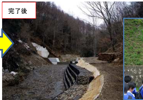
↓ 施工後の状況
