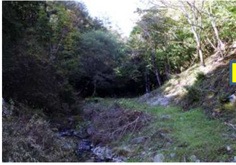
↓ 施工前の荒廃状況
