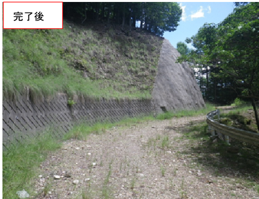
↓ 林道の開設状況
