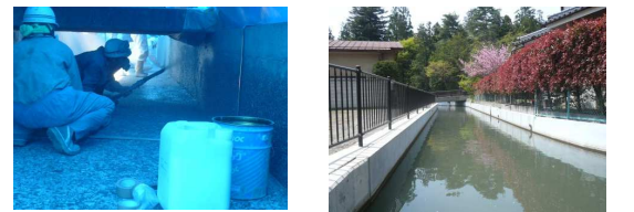
(上) 補修工法(韌性モルタル吹付工法)によるコスト縮減(矢原堰排水路)
