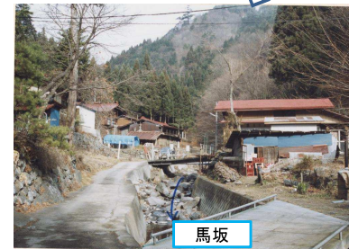
谷止工の施工により溪床の土石の安定とともに溪岸の植生が回復している。(H22施工)
