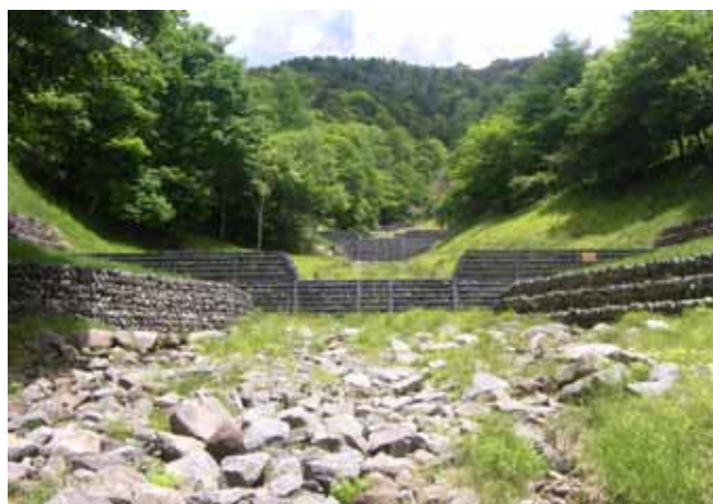
谷止工施工後
