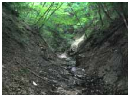
H18, NO,2谷止工施工前
