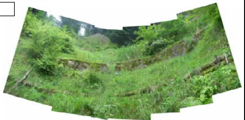
山腹工(H15-18) 現況
