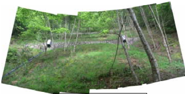
山腹工(H11-12) 現況
