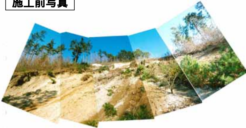
山腹工(H11-12) 施工前
