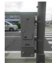
信号機の制御機の更新
