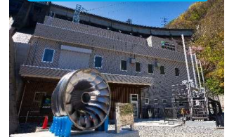
大規模改修後の発電所（完成）
