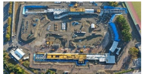
工事施工状況全景
