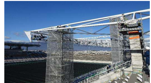
アルウィン復旧工事
