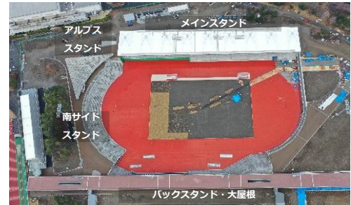
松本平広域公園陸上競技場施工状況
