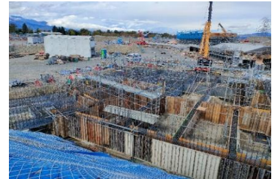
バックスタンド工事
