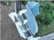
地すべりを抑制する堰堤
