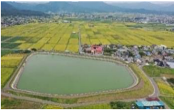
防災工事を実施したため池
