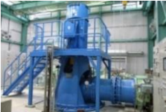
更新が完了した排水ポンプ
