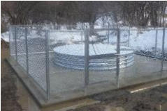
補修が完了した集水井
