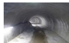
【水路トンネルの補強】
