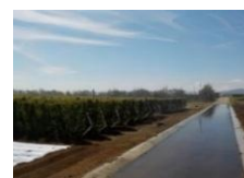
【水路兼用農道の整備】
